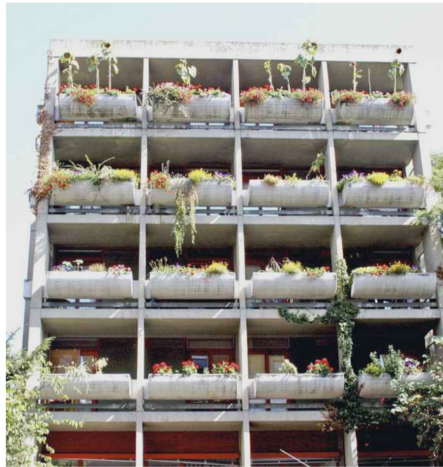
Viele Sorgen hinter der bunten Blumen-Fassade: Die Oberzeller Schwestern bieten im Antonie-Werr Haus Frauen in Notsituation Hilfe und Rückhalt an. Foto: Rainer Reichert
